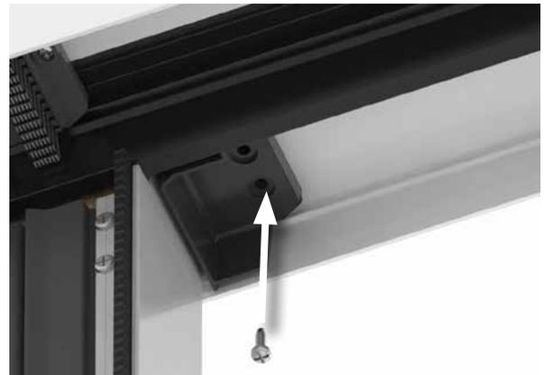
Z. Coloque calzas entre el marco y la abertura sin terminar por encima de la tapa fija y, luego, perforo un orificio guía de 5/32" (3.96 mm) en el orificio vacío en la tapa fija. El orificio guía atravesará el marco y entrará en la abertura sin terminar.
