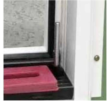
**AVISO** Cada panel incluye un tornillo de alineación con cabeza Philips en la ubicación de bisagra superior que se utiliza para mantener la canaleta de aluminio central en su lugar durante el envío. Estos tornillos deben retirarse antes de instalar los aditamentos de bisagra en cada panel.
