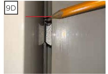
E. Alinee la placa del pestillo del seguro de gancho superior con el borde inferior de la abertura aproximadamente 3,17 mm por debajo de la marca del lápiz. Con una broca de 3,57 mm, taladre de forma previa los dos orificios y asegure la placa del pestillo del gancho con los tornillos.
