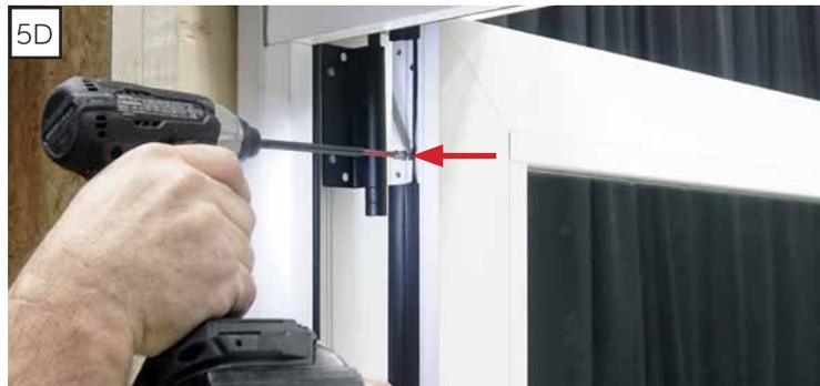
E. Mantenga el panel perpendicular al marco y atornille la hoja de la polea de pivote superior en el panel.
